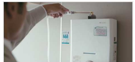
定期保安巡回の様子
